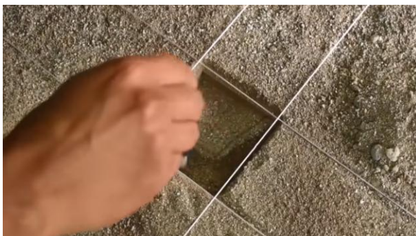
Figura 14. Trazo con hilo de zapatas aisladas.
