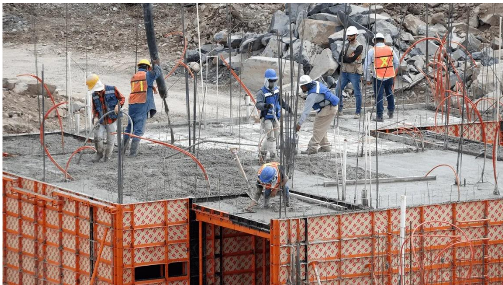
Figura 1.18 En el ejemplo se ve el vaciado de concreto en losa.
