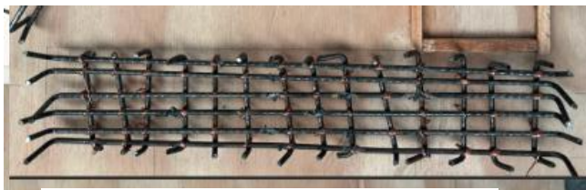
Figura 17. Cortes y armado de parrilla para zapata corrida.
