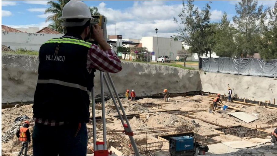
Figura 13 Preparación de terreno para iniciar la construcción.
