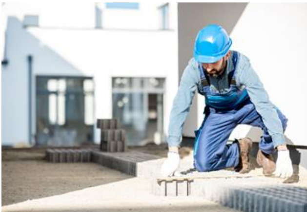
Canva. (2026). Fotografía de colocación de piso de porcelanato [Fotografía]. https://www.canva.com
