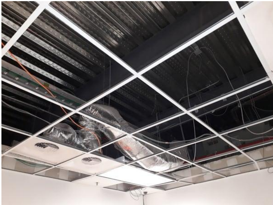
Imagen 1.31. Con estos tipos de cancelería se puede construir un falso plafón
