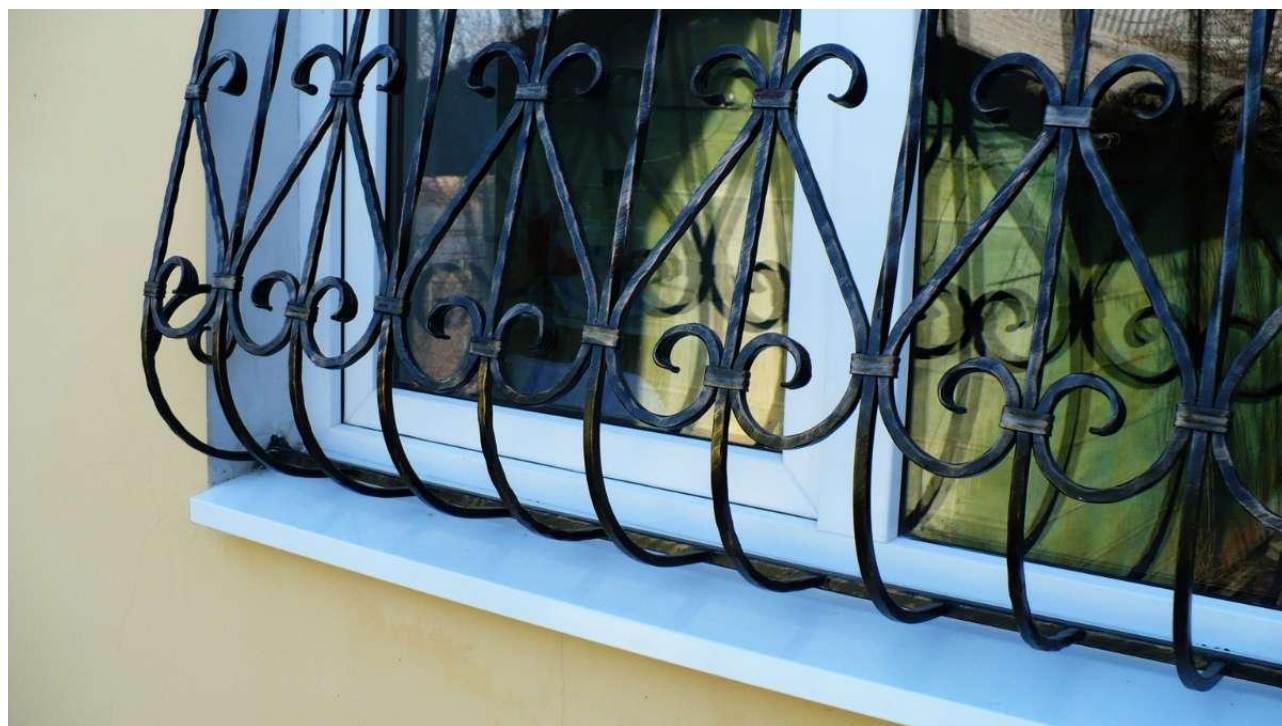
Imagen 1.39. Protecciones de herrería
