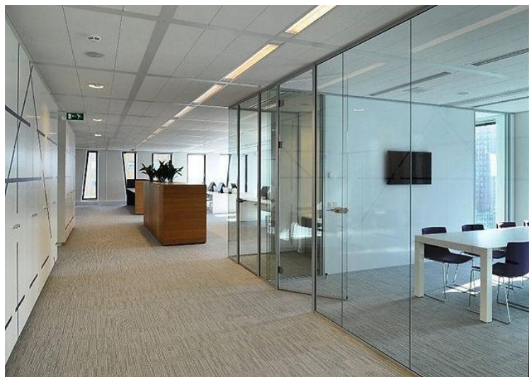
Imagen 1.30. La cancelería se puede emplear para construir muros divisorios
